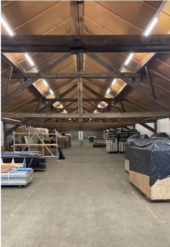
Temporäres Zwischenlager Post Baulogistik © RE-WIN
