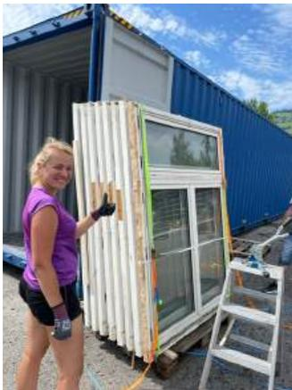
2. 8 Fenster aufreihen → Spannset leicht anziehen → ganzer Block aufrichten und Spannset anziehen.
