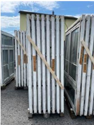
3. Diagonale Dachlatte (1.2m) mit 4 Schrauben direkt im Rahmen befestigen. Ggf. darauf achten, dass die Latten an den Seiten über Kreuz orientiert sind zur besseren Aussteifung. → Bei Aluminium und Plastikrahmen selbstbohrschrauben nutzen. Darauf Achten, dass die Glasseinheit nicht beschädigt wird.
